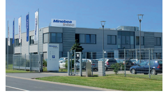
6 Minebea Intec Bovenden GmbH & Co. KG (Germany)
