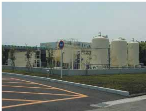
藤沢製作所の廃水処理施設
