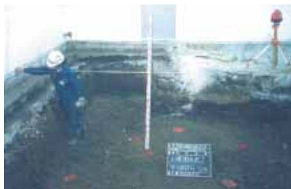
汚染土壌の除去後
