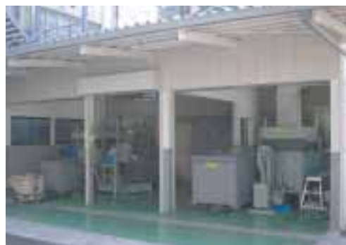
大森製作所の新設切粉置場
