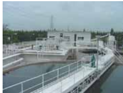
タイ / バンパイン工場の廃水処理施設
